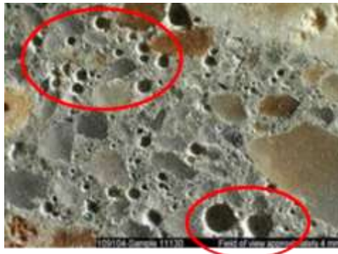
Fig.4. voids in concrete.
