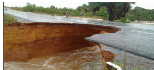
Figure 7. A. Break the BR-174 tubes. Source: Folha de Boa Vista, 2012.
